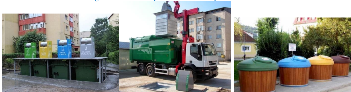
Figura 7-1 Modalități de colectare a deșeurilor reziduale
